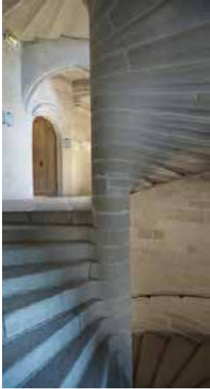
L'escalier de la tour de Rohan
